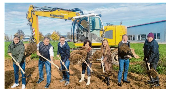
Da fliegt die Erde: Die Familie Stapf, Inhaber der Stako-Gruppe, Generalunternehmer, Planer und Bürgermeister Jürgen Silberzahn (rechts) beim Spatenstich in Wolpertshausen. Foto: Oliver Färber
